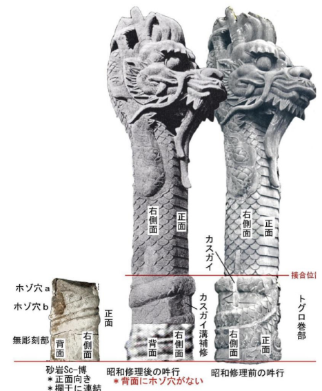
図 3：吡形大龍柱の背面（欄干に連結するホゾ穴がない）
