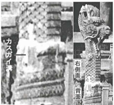
写真 1：昭和修理竣工前の吡形大龍柱とトグロ巻き部背面の拡大。東京大学大学院工学系研究科建築学専攻所蔵
